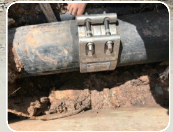
▲ PE Pipe Repair
